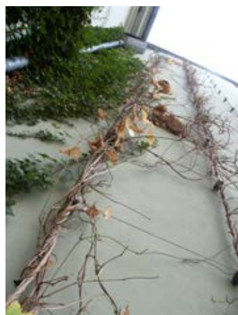
Obrázek 23: Správná konstrukce pro podražec, v době vegetace vytvoří olistěná rostlina souvislou plochu i při velké vzdálenosti lan
